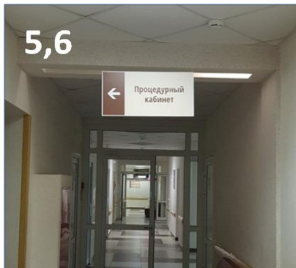
Навесной элемент навигационной системы в коридоре перинатального центра
